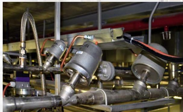
Alternativ zu einer konventionellen Verrohrung mit einzelnen Ventilen, werden platzsparende Ventilblöcke, die die Instandhaltung vereinfachen und Wärmeverluste reduzieren, immer beliebter.
