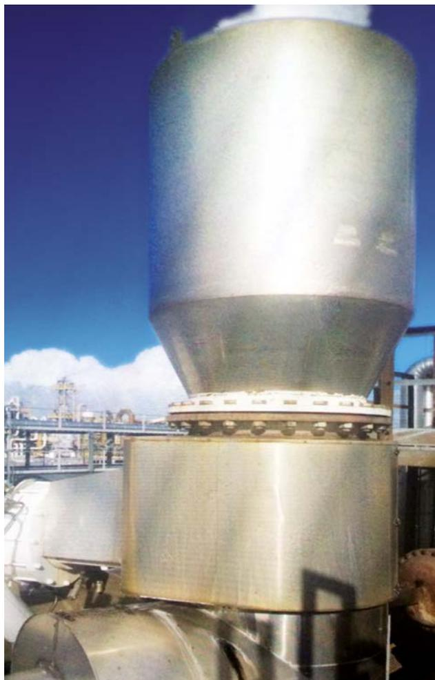
**Abb. 3** Dieses isolierte Segmentplattenventil hat die Nennweite 500 und wird an dieser Stelle als Endarmatur mit aufgesetztem Schalldämpfer (Silencer) in Nennweite 800 betrieben.
