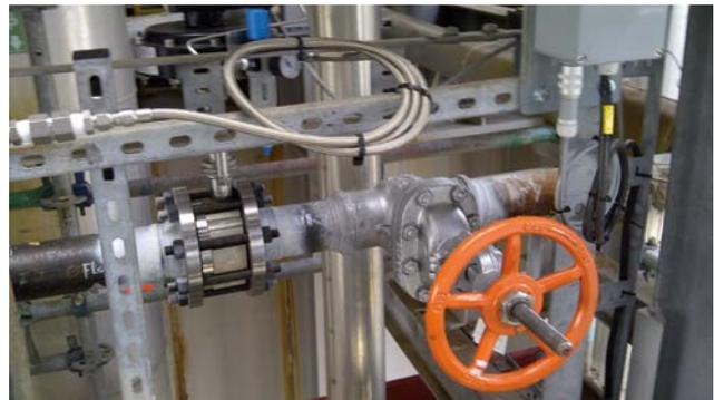
**Abb. 6** Das neue Gleitschieberventil mit 8049 Stellungsregler.
