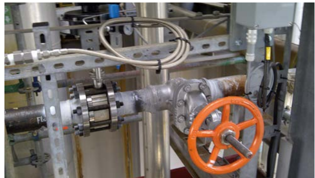
Abb. 6 Das neue Gleitschieberventil mit 8049 Stellungsregler.
