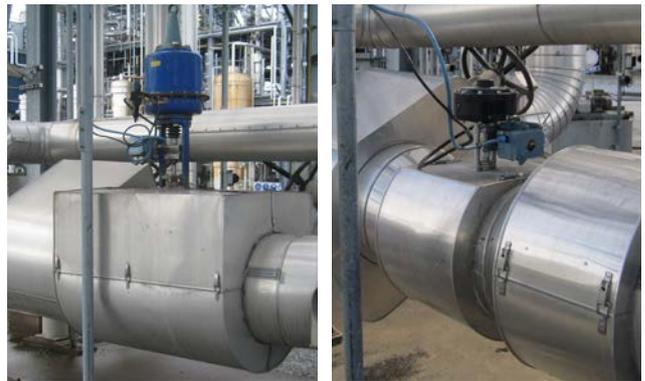
Vorher und nachher – Gleitschieberventil in DN250 im Einsatz in der Dampfübergabestation bei EVAL Europe N.V. in Antwerpen.
