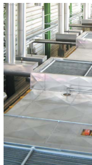
Trocknungsanlage im Pelletierwerk Holzwerkstoffe Eberswalde
