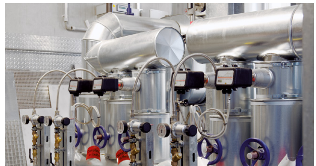
Zwei parallel geschaltete Gleitschieberventile sichern eine präzise Kondensatregelung für einen optimalen Wirkungsgrad der Heizkondensatoren.
