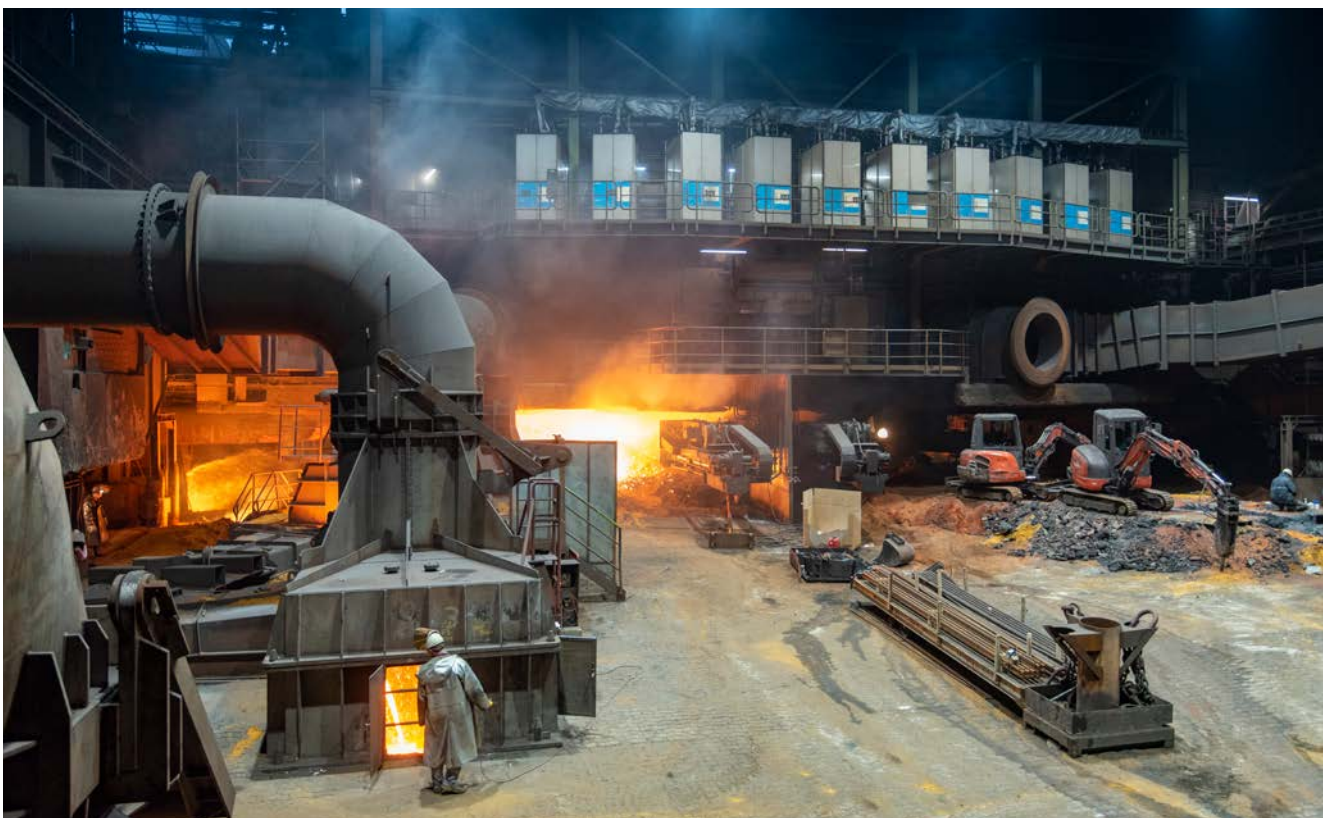
Schmelgern 1 gehört zu den modernsten Hochoföen der Welt mit einer potentiellen Leistung von 10.000 t pro Tag. An den Blasformen wurden im Laufe des Projekts 40 SIP-Boxen (grau-blau im Bild) installiert, welche starke, diskontinuierliche Impulse mit technischem Sauerstoff in das Koksbett injizieren um eine bestmögliche Tiefenwirkung zu erzielen.
