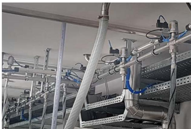
„Notre vanne trois voies à commande pneumatique, dite vanne 3/2 voies type 7081, est prévue pour une capacité de commutation élevée requise“, explique Heiko Renn.
