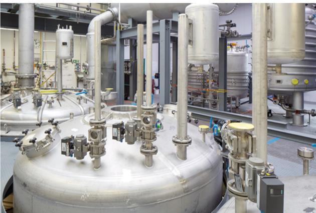
Installation de deux réacteurs pour la polymérisation de colle ; sur les conduites d'alimentation, les systèmes de vannes (vannes à secteur sphérique) sont déjà montés.
