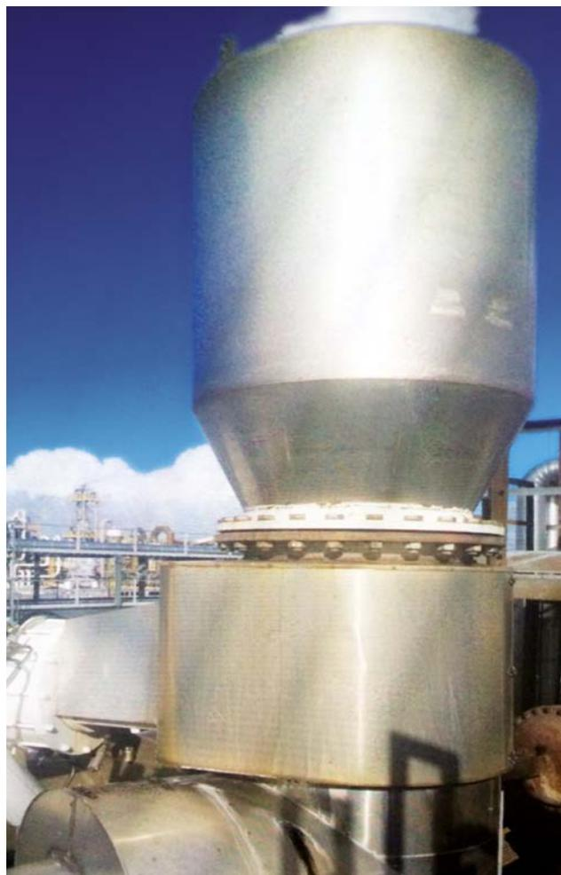
**Figure 3°** : Cette vanne segment à disque calorifugée a un diamètre nominal de 500 et est utilisée à cet emplacement comme vanne d'évent associée à un silencieux en diamètre nominal de 800.
