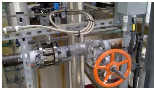
Fig. 6 La nouvelle vanne à glissières avec positionneur 8049.
