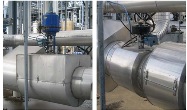
Avant et après - Vanne à glissière DN250 en fonctionnement dans la station de filtrage de vapeur de EVAL Europe N.V. à Anvers.
