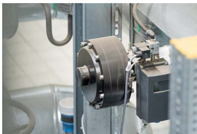
Dans la conduite primaire aller, six vannes à glissière sont utilisées pour la régulation du débit.
