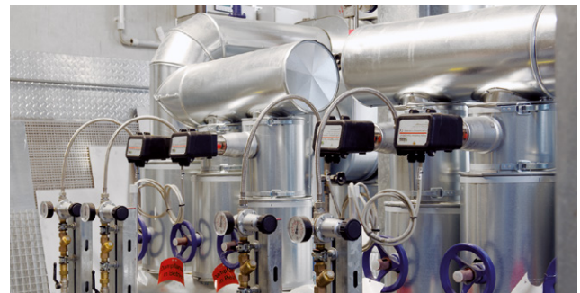
Deux vannes à glissière montées en parallèle assurent une régulation précise des condensats pour un degré d'efficacité optimal du condensateur de chauffage.
