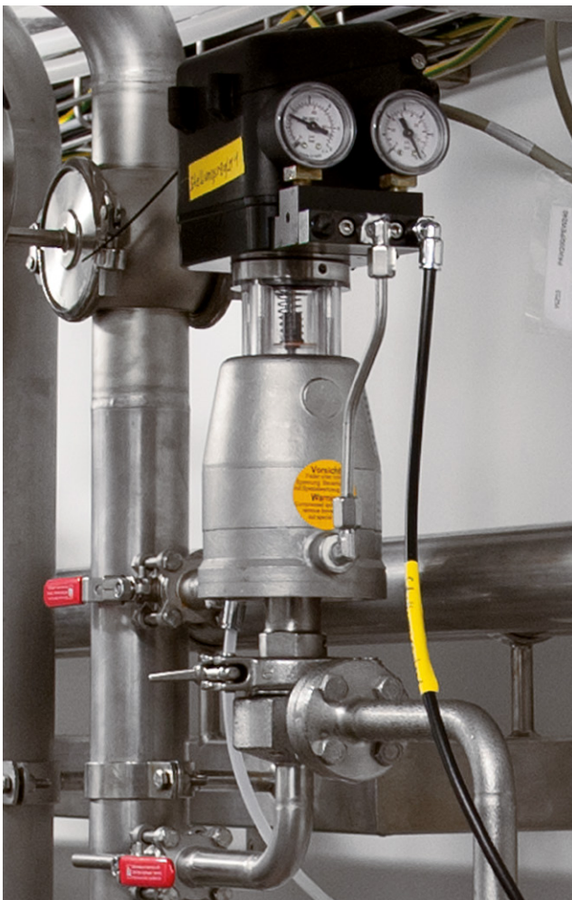
Photo 2 La vanne d'équerre de la série 6000 de Schubert & Salzer Control Systems dans l'installation Oktoberfest-conteneurs de Paulaner.
