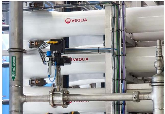
Dans chacune des douze unités d'osmose inverse, une vanne à glissière DN125 et une vanne à glissière DN50 sont utilisées pour réguler la pression.
